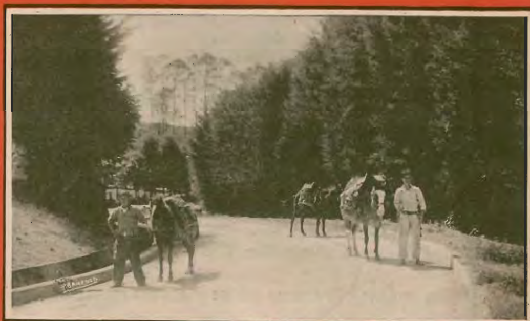
Vista de una de de las modernas carreteras de concreto, que comunican las zonas cultivadas de café con las estaciones del Ferrocarril, facilitando el transporte para la exportación.
